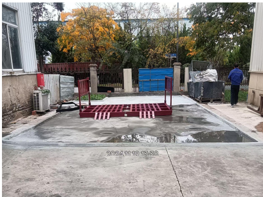
洗车平台围堰
