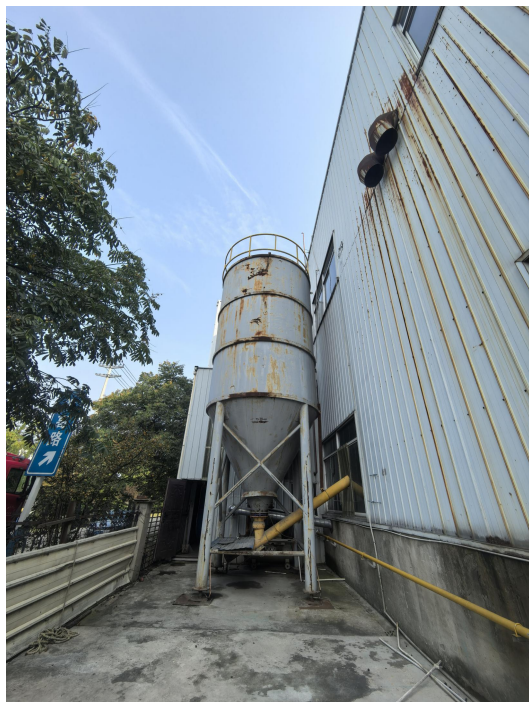
水泥仓（仓顶密闭管道收集）
